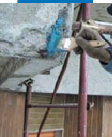
Нанесение Mapefer 1K кистью на арматуру балкона
