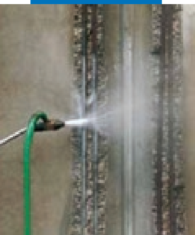
Очистка стальной арматуры
