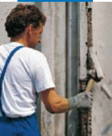
Удаление поврежденного бетона
