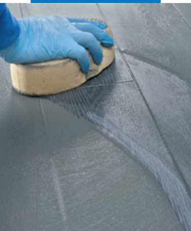
Окончательная очистка плитки с помощью целлюлозной губки
